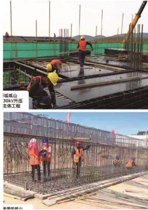
呱呱山330kV升压站主体工程
